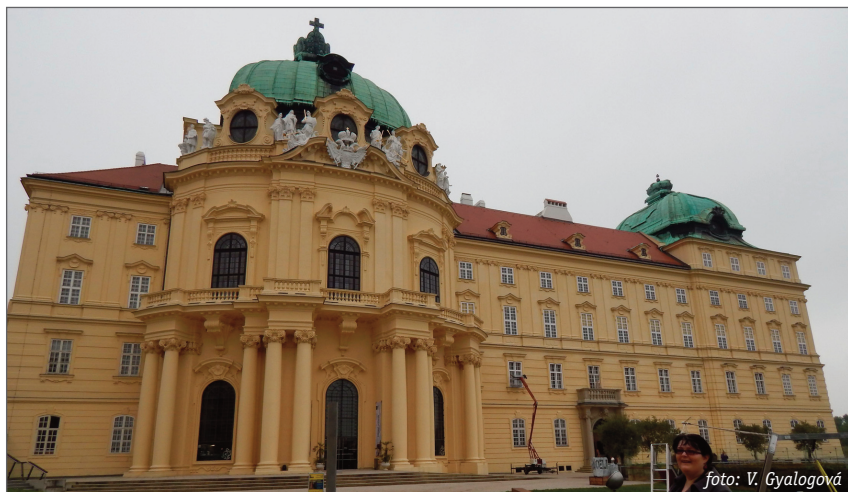
Pohľad na barokový vstup do kláštora
