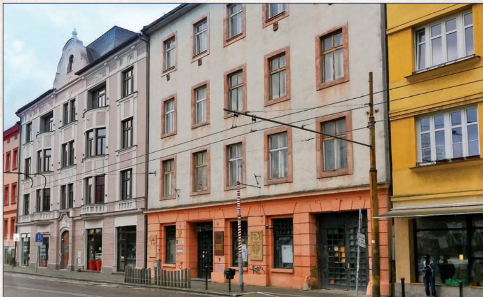
Sídlo Bratislavského bábkového divadla na Dunajskej ulici č. 36
