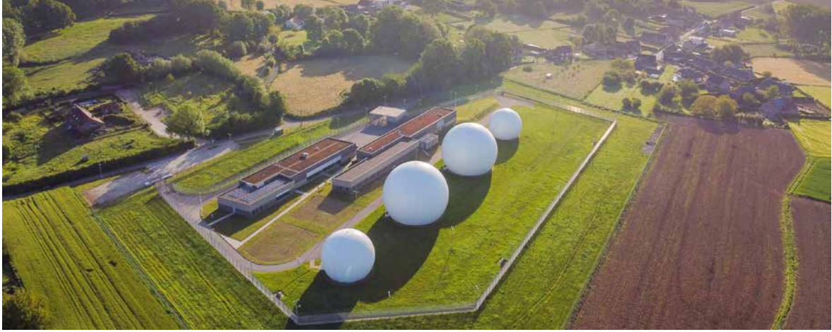
Vue aérienne de la station terrienne de satellite de l'OTAN – Kester (Belgique), juin 2023.
