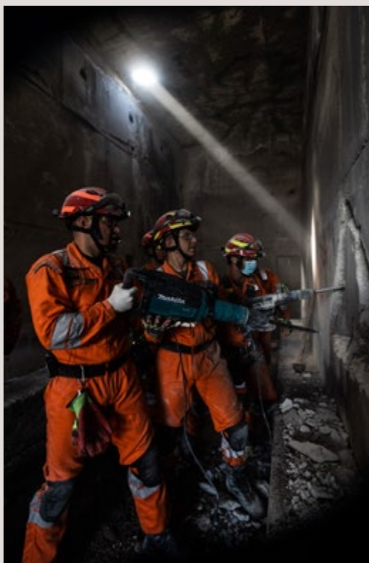
Une équipe grecque de recherche et sauvetage se prépare à démolir un mur en ciment pour secourir une victime lors d'une simulation organisée dans le cadre de l'exercice de réponse aux catastrophes North Macedonia 2021 – Région d'Ohrid (Macédoine du Nord), septembre 2021.
